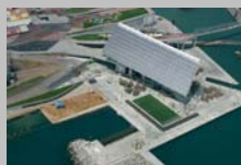
1491. Placa fotovoltaica - Zona Forum.
